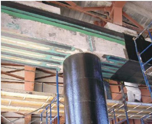
Kolonların enine doğrultuda LP sargılama ile güçlendirilmesi
