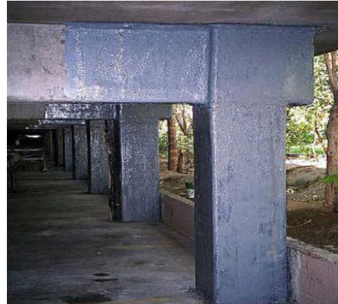
Kolonların enine doğrultuda LP sargılama ile güçlendirilmesi
